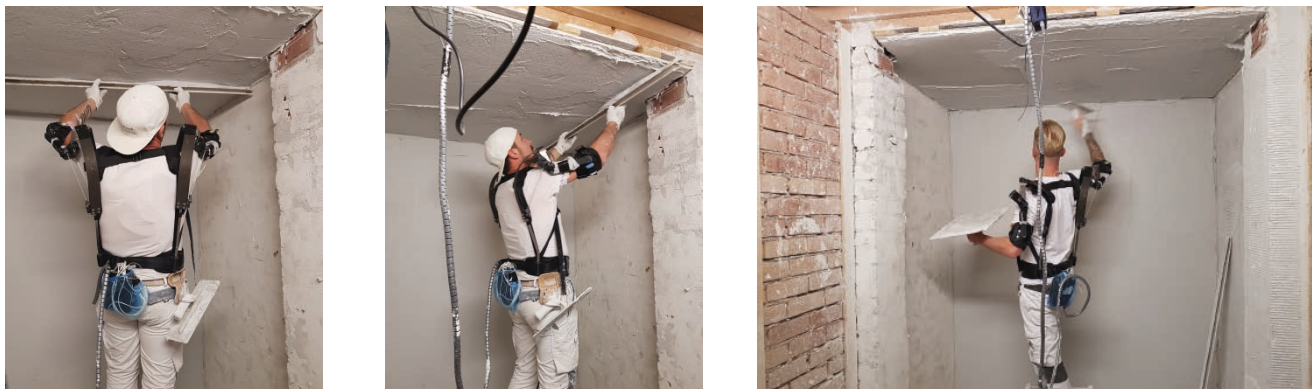
Figuur 1: Stukadoors aan het werk met een arm-ondersteunend exoskelet (Skelex) tijdens het experiment door TNO en Knauf.
