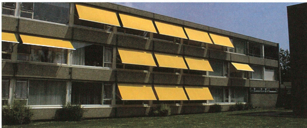
Het tijdig schakelen van de buitenzonwering is essentieel voor het realiseren van een acceptabel binnenklimaat
