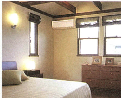
Splitunit: De binneneenheid is in de hoek van de kamer zichtbaar
