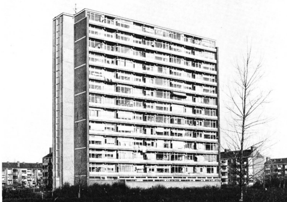
Fig. 1. Het in de tekst genoemde flatgebouw, waarvan de onderste vier woonlagen voorzien zijn van enkelglas en de overige woonlagen gedeeltelijk van dubbelglas. Percentage glas in de gevel: 63%.
