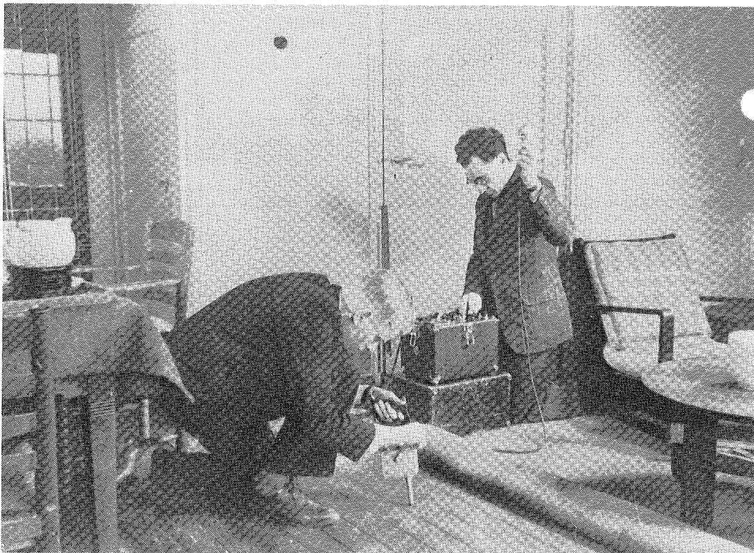
Figuur 1. Een meting van de contactgeluidisolatie in woningen anno 1945.
