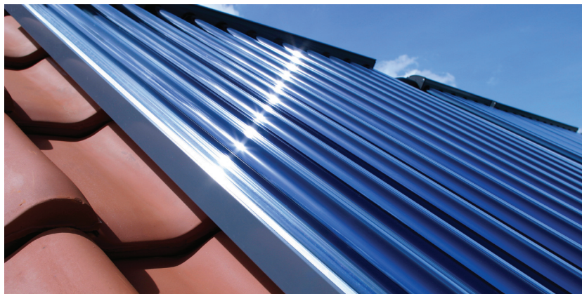
Vacuümbuiscollectoren op het dak van een huis.
