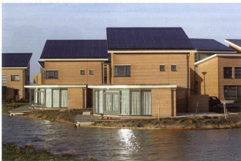
Een dak met zonnepanelen levert gemiddeld per jaar genoeg elektriciteit voor een huishouden (foto: Mayersloot, Broek op Langedijk. Architect: Tjerk Reijenga).
