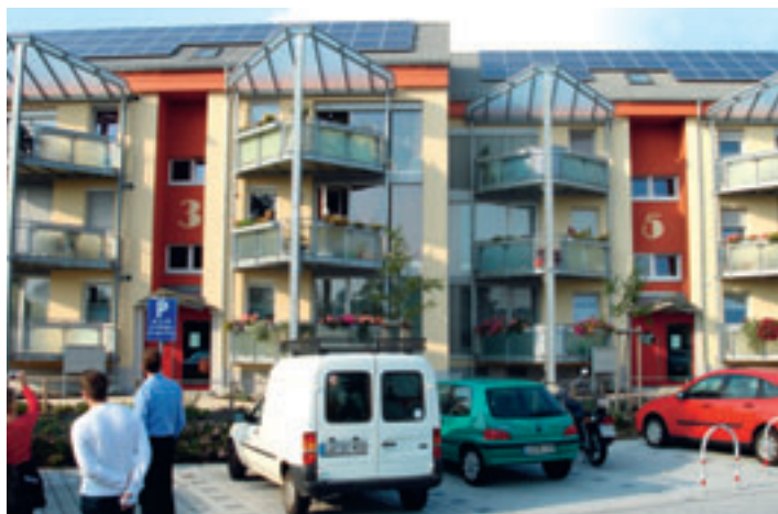
2. Bestaande woningen, na renovatie tot passiefhuizen. Het energiegebruik voor ruimteverwarming is met een factor 15 omlaag gebracht.
