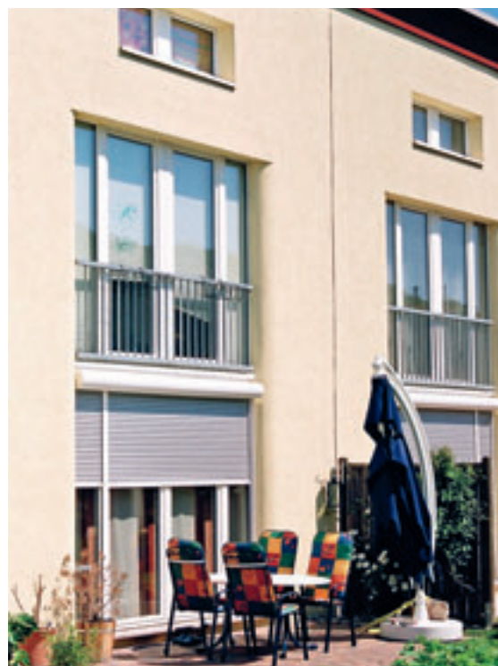
1. Passiefhuizen in Heidelberg. Om optimaal toetreding van daglicht te krijgen, is de isolatie rondom de kozijnen afgerond. Dit beïnvloedt het isolerend vermogen niet.
