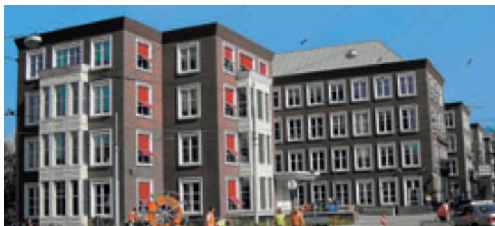
1. Bij het Postbankgebouw in Amsterdam is optimalisatie toegepast van de luchtbehandelingskast.
