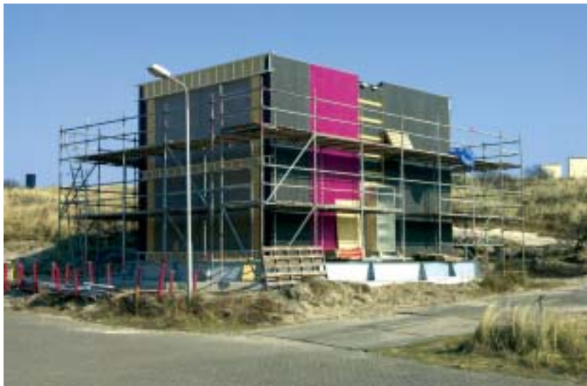
Draaibare testfaciliteit in aanbouw op het ECN-terrein. Het gebouw kan drijven in een bak met water en kan daarom in elke gewenste stand worden geplaatst.
