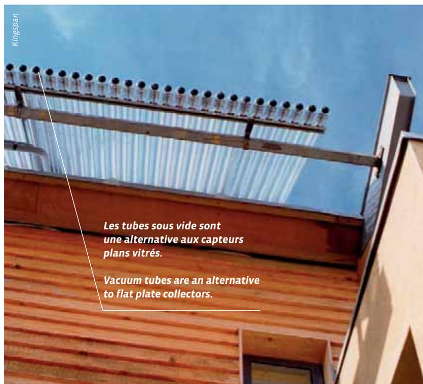
Les tubes sous vide sont une alternative aux capteurs plans vitrés.
