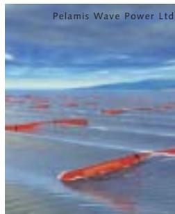
Developed by Pelamis Wave Power, le houlogénérateur Pelamis est le premier à faire l'objet d'un contrat commercial. Sorte de serpent de mer de 150 m de long “ondulant” sur les vagues, l'engin possède une puissance nominale de 750 kW. Une ferme de 2,25 MW est en phase d'installation au Portugal, et pourra être complétée dans les années à venir pour atteindre 22,5 MW. Un autre projet de 4 MW, situé sur les îles Orcades, au large de l'Écosse, a également été annoncé.
