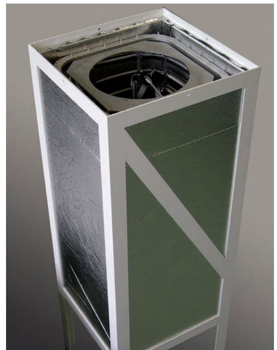
De compacte warmteopslag in aanbouw. De beplating en het deksel moeten nog worden aangebracht.
