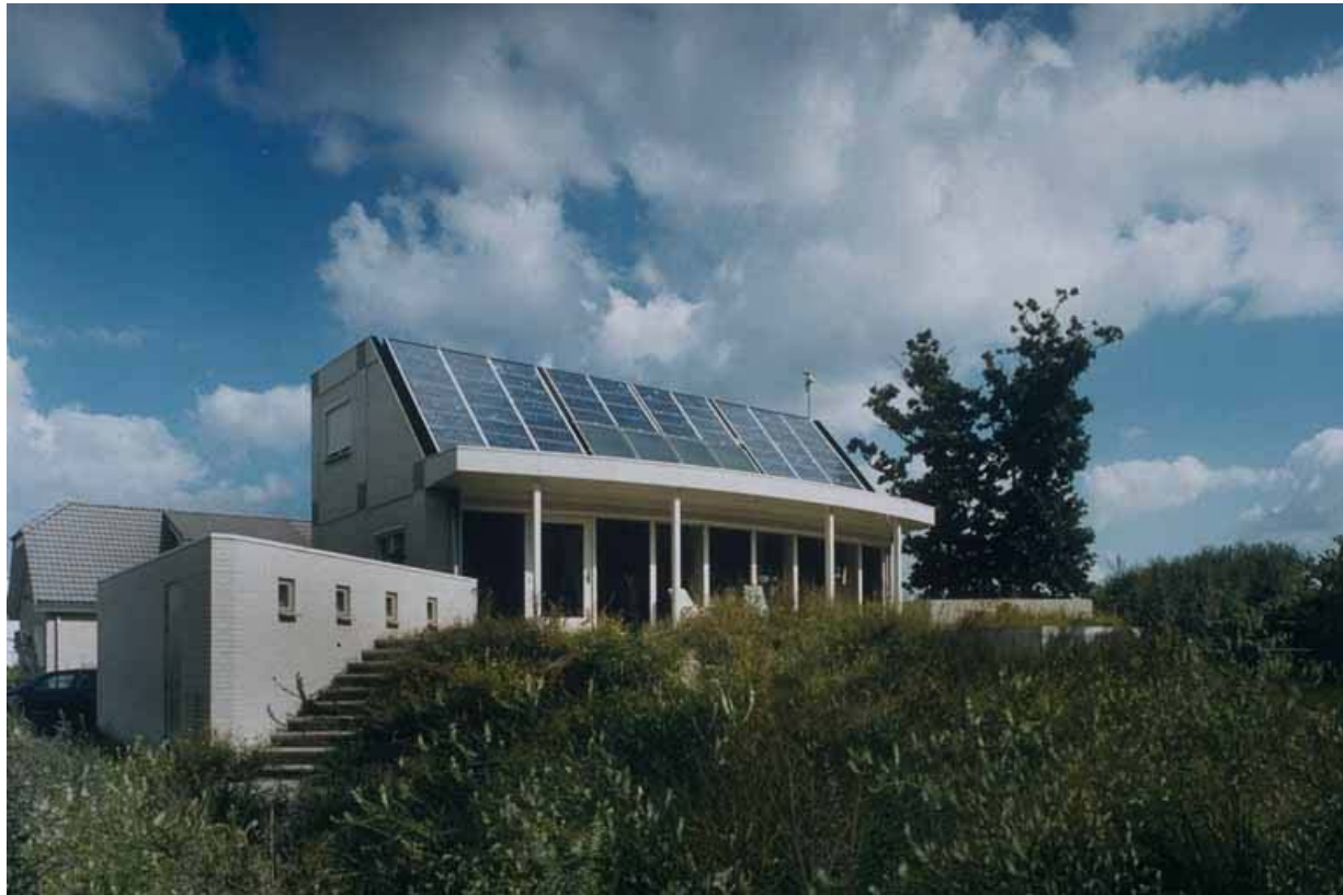
Fig. 2 Solarhaus in Zandvoort
