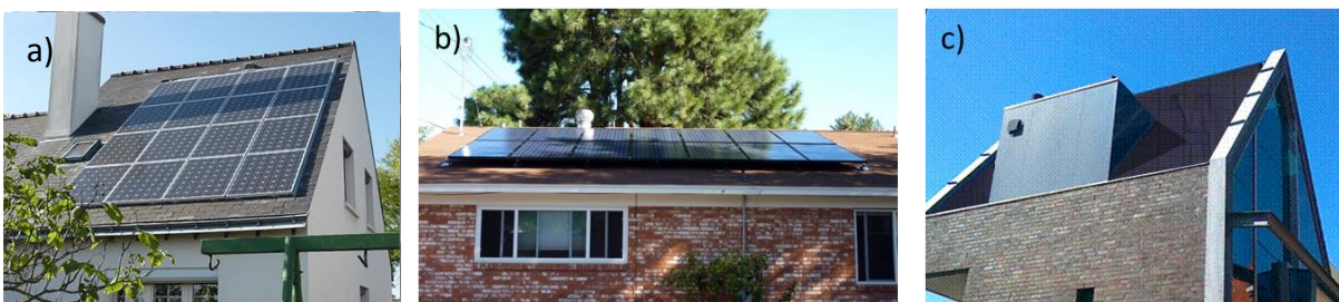
Fig. 1. a) Dak met zonnepanelen met een grote schaduw van de schoorsteen. b) Dak met zonnepanelen die deels beschaduwd worden. c) Oplossing van dit project waarbij de panelen over het hele dak kunnen worden gelegd met marginale reductie in opbrengst.
