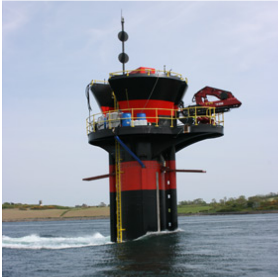
Figuur A.39 De SeaGen getijdeturbine van 1,2 MW
