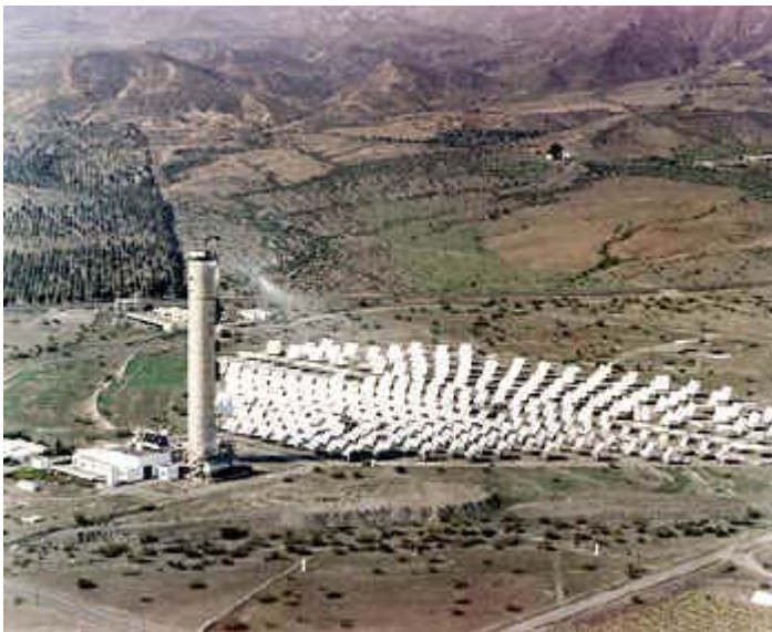
Figuur A.38 Zonne-energiecentrale te Almeria in Spanje
