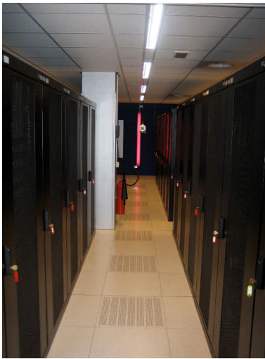
Figuur 2: Computerapparatuur staat opgesteld in rekken in grote ruimten waar opgewarmde en gekoelde lucht kunnen mengen. Foto's: ECN.
