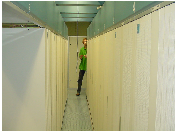
Figuur 2: Computerapparatuur staat opgesteld in rekken in grote ruimten waar opgewarmde en gekoelde lucht kunnen mengen. Foto's: ECN.
