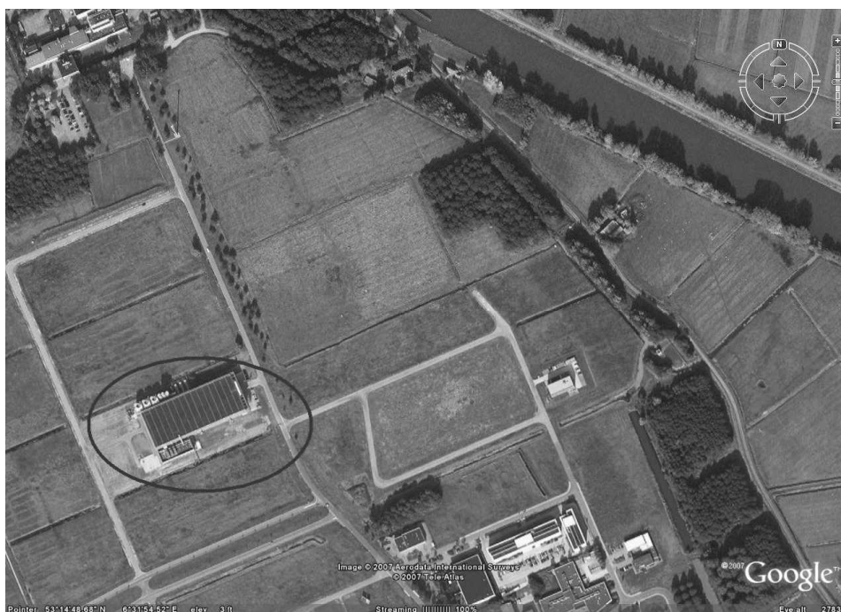
Figuur 1: Datahotel in Groningen, gebouwd rond 2000 (omcirkeld). Foto: Google Earth
