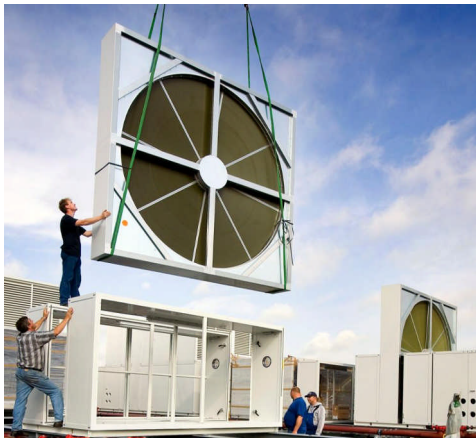
Figuur 11: Foto en een principe schema van de toepassing van verticaal geplaatste koudewielen en op het dak van een bestaand datahotel; Foto: Hamer installatietechniek, Figuur 12 PinkRoccade Getronics, KPN en UpTime Technology
