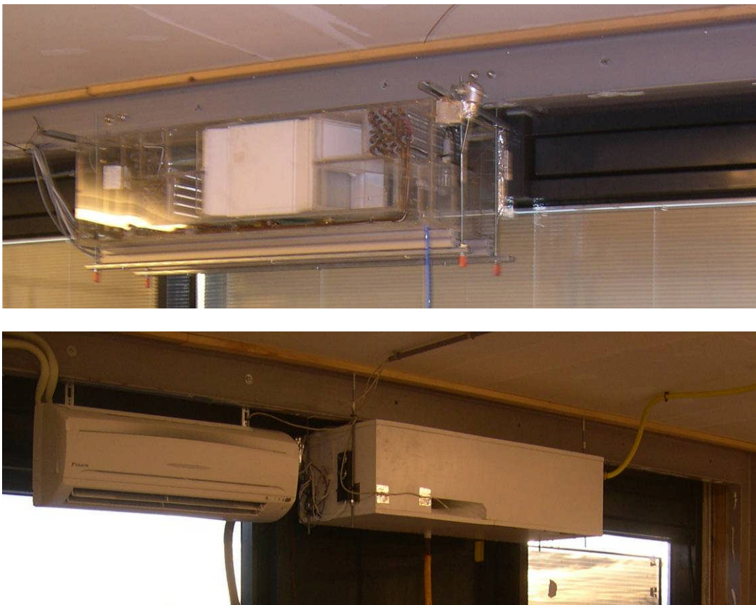
Figuur 17 De installaties op de begane grond (onder) en de verdieping (boven) in de draaibare onderzoeksfaciliteit van ECN
