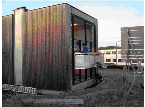
Monteren stijl en regelwerk
