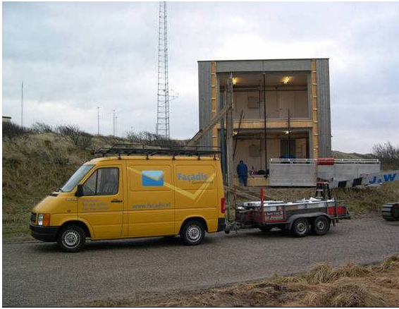
Verwijderen oude testgevels
