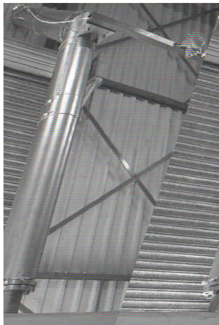
Figuur 2.10 Rookgasafvoer microgasturbine. Rechts van de afvoer buiten en linksboven bij de afvoer binnen is de flexibele leiding te zien voor het bemonsteren van rookgas.
