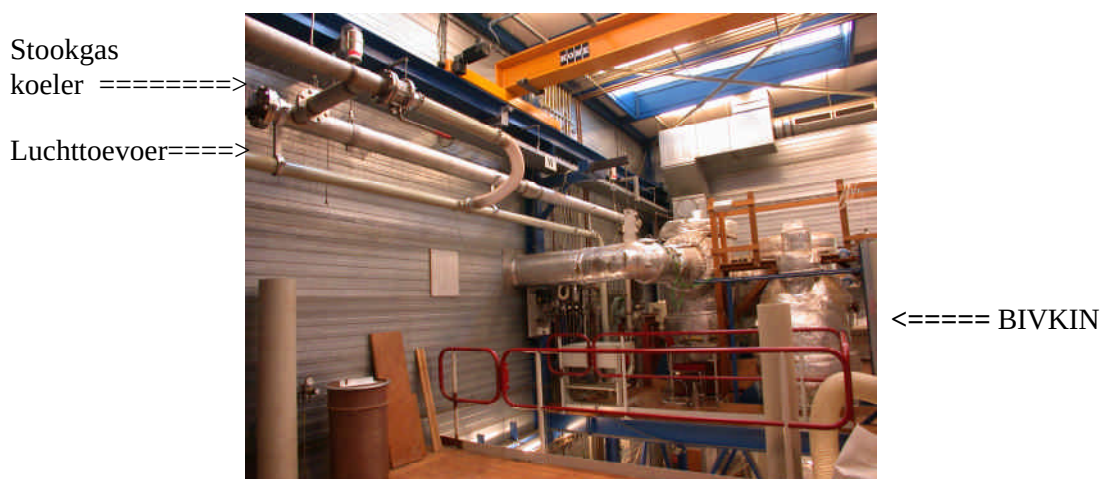
Figuur 4.2 Foto van stookgaskoeler en luchttoevoer
