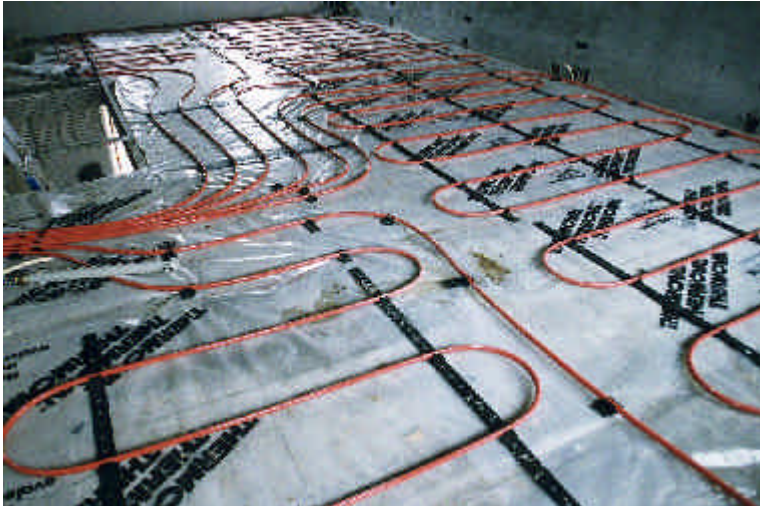
Figuur 3.3 Het aanbrengen van vloerverwarming
