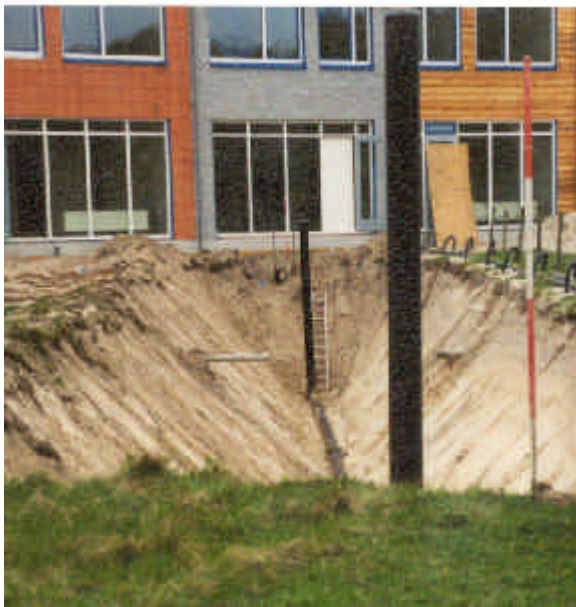
Figuur 3.7 Lucht-bodem warmtewisselaar van woning C tijdens het aanbrengen
