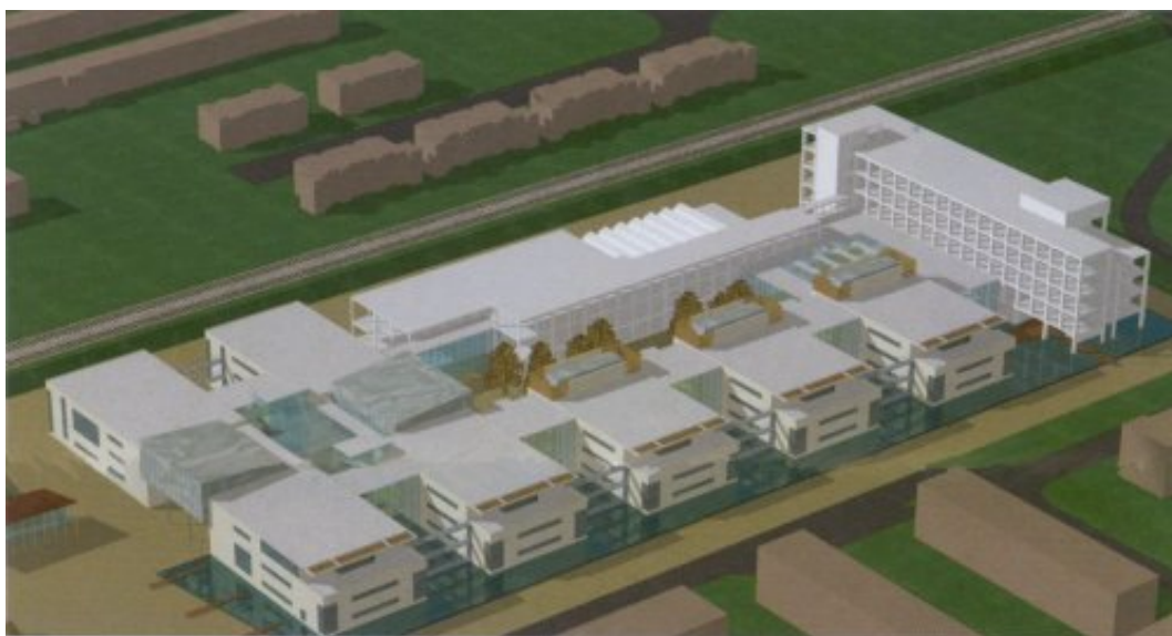
Figuur 1 'Artist Impression' van de unilocatie van de Hogeschool Haarlem. De hoogbouw rechts en het lange gebouw met de sheddaken zijn bestaande bouw. De blokvormige gebouwdelen van de nieuwbouw zijn gescheiden door grotendeels glazen 'vides' (te zien aan reflecties in het water). Links onder het glazen dak is de kantine gesitueerd.
