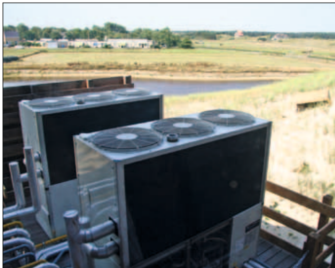
Figuur 15 Gasmotorwarmtepompen bij het Natuurcentrum Ameland (paragraaf 7.8). Bron: BDH
