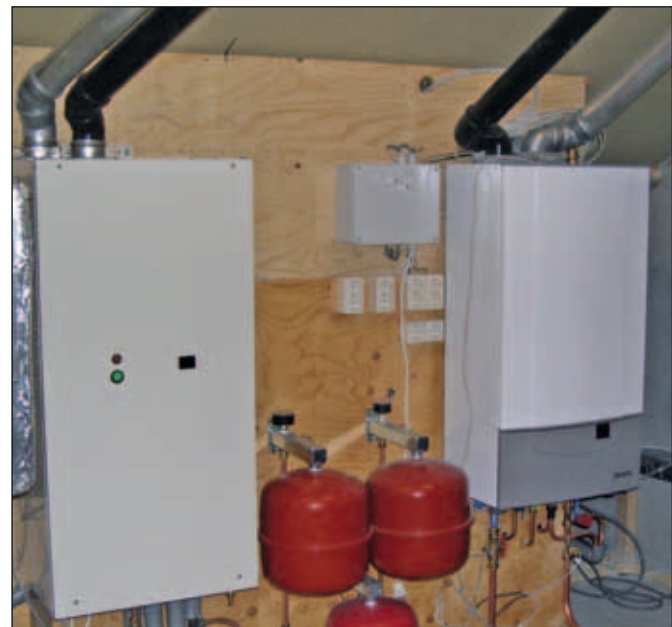
Figuur 35 Gasabsorptiewarmtepomp in de testopstelling bij ECN (links de GAHP, rechts een CV-ketel). Bron: ECN
