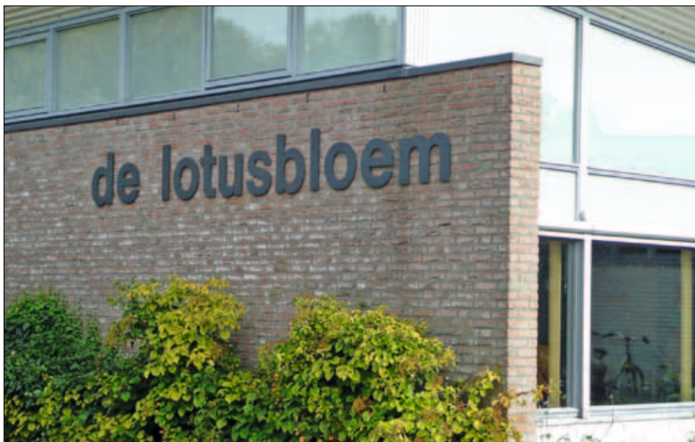
Figuur 9 Buitengevel zwembadgedeelte kinderdagcentrum. Bron: Techneco
