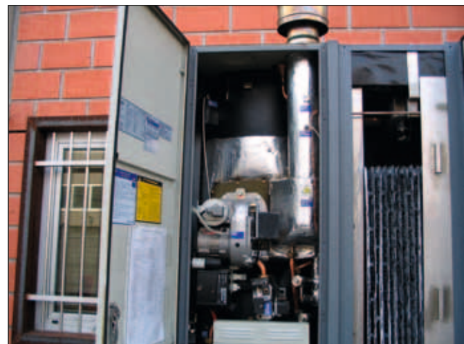
Figuur 33 Gasgestookte absorptiewarmtepomp van Broad, voor huis- houdelijke toepassingen. Bron: BDH
