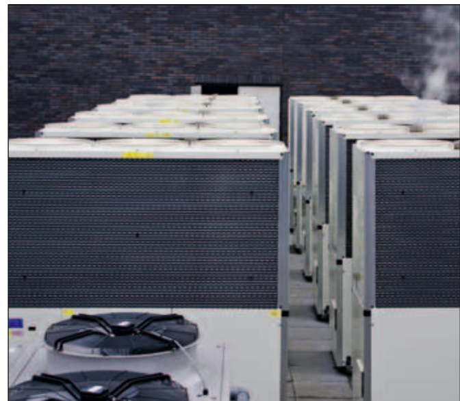
Figuur 15 Warmtepompen op het dak van een winkelcentrum in Geleen. Bron: Gasengineering
