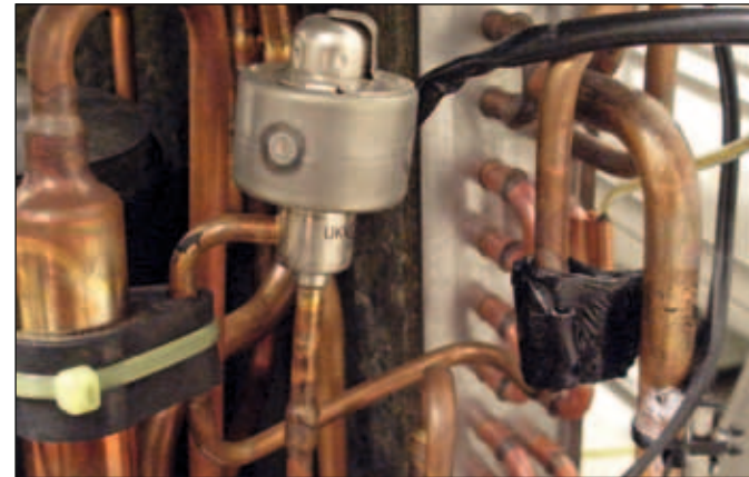
Figuur 19 Elektronisch expansieventiel. Bron: KGT
