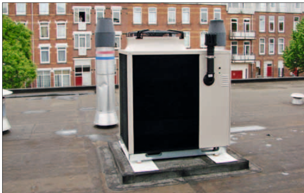
Figuur 12 Opstelling van de gasabsorptiewarmtepomp op het Sportfondsenbad in Rotterdam. Bron: Sportfondsen Nederland
