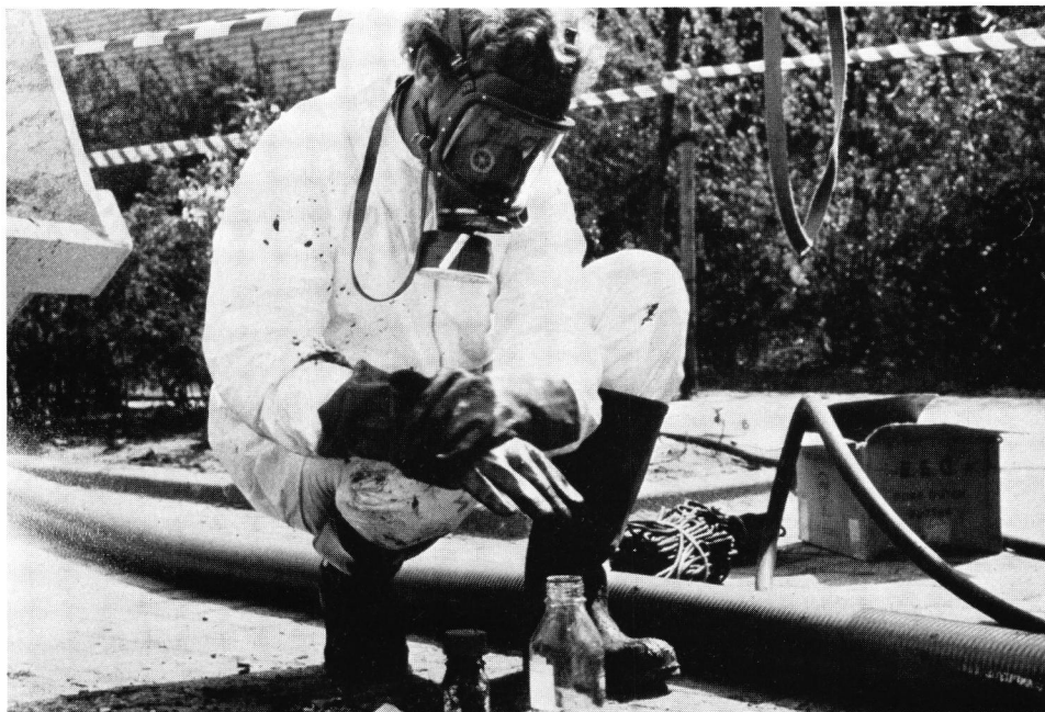
Continue meting van vluchtige stoffen tijdens de saneringswerkzaamheden dient tot het standaardpakket van maatregelen te behoren. Foto: NIA-archief
