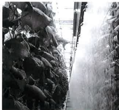
-Figuur 2- Vallende waterdruppels vormen een watergordijn dat warmte en vocht uit de kaslucht opneemt. Een opstelling per 10 m levert een koelvermogen van gemiddeld 500 W/m 2 . Rechts de opvanggoot.
