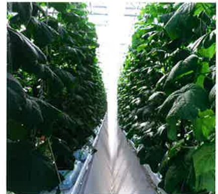
-Figuur 2- Vallende waterdruppels vormen een watergordijn dat warmte en vocht uit de kaslucht opneemt. Een opstelling per 10 m levert een koelvermogen van gemiddeld 500 W/m 2 . Rechts de opvanggoot.
