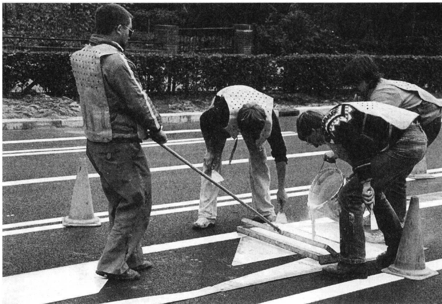
WEGMARKERING GIETEN IN PLAATS VAN SPIJTEN FOTO SJAAK RAMAKERS
