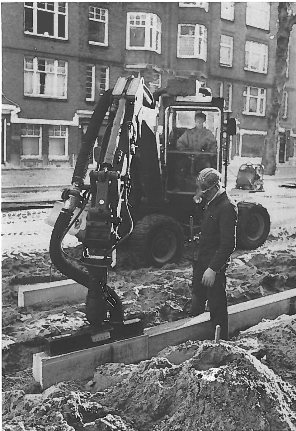
Mechanisch stellen van trottoirbanden. Foto: Dick Vader
