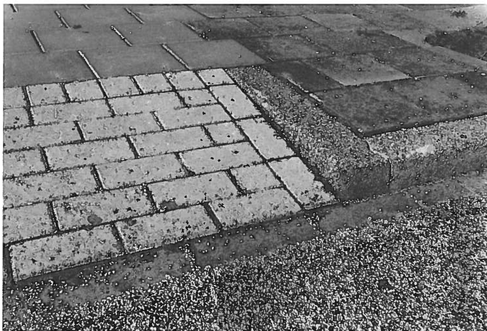
Zware inritblokken vervangen door een andere constructie. Foto: Arbouw
