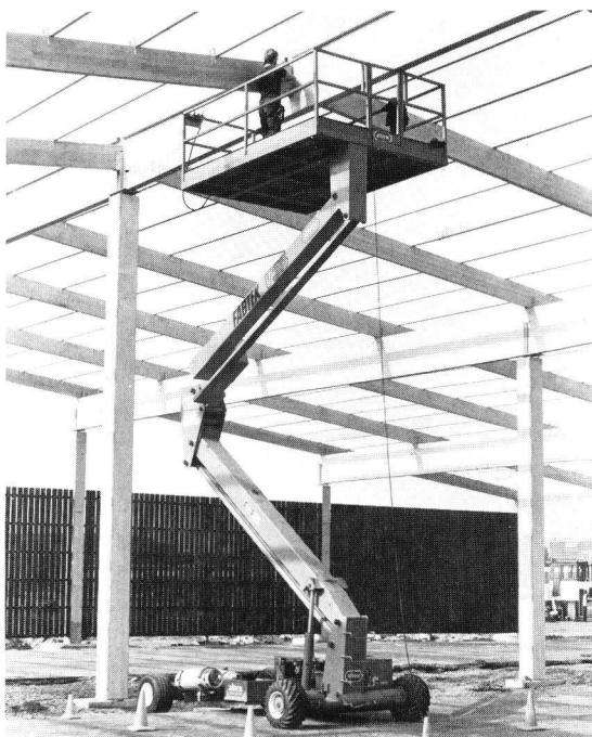
Een knikarmhoogwerker in actie bij montagewerkzaamheden aan een dakconstructie.
