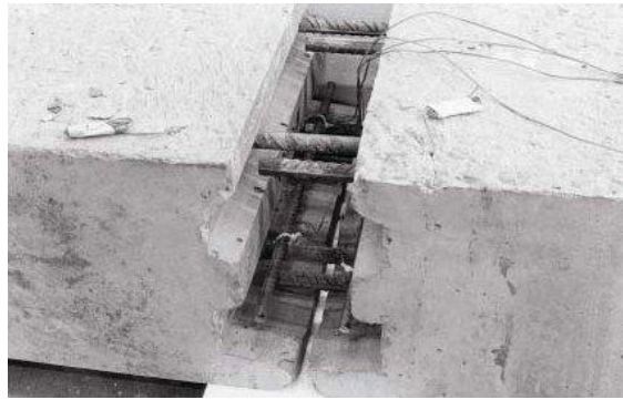
Figuur 2-6 een verbindingsstrook tussen twee rijdekelementen, klaar om te storten
