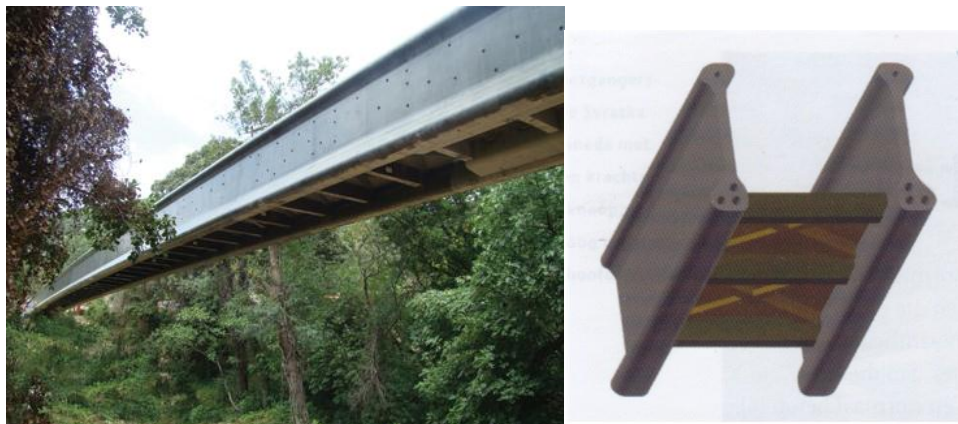
Figuur C16: Trogbrug over de Gorge de l'Herault
