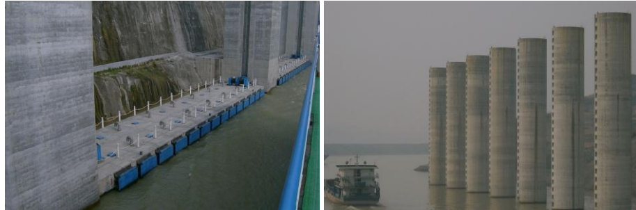
Figuur C30: Remmings en geleidewerken in de sluisen bij de Drieklovdendam (China)
