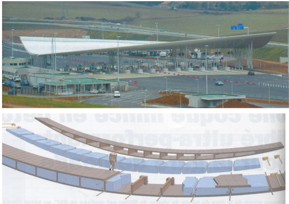
Figuur C25: Overkapping van het tolstation in Millau
