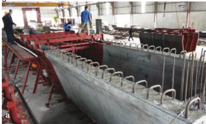
Figuur 2-3 De bekisting van de prefabdelen voor de autobrug bij Kampung Linsum, Maleisië; (50 m)
