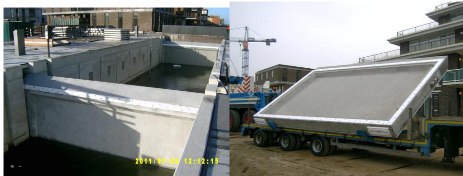
Figuur C29: Schuifdeuren in een van de sluisen op IJburg
