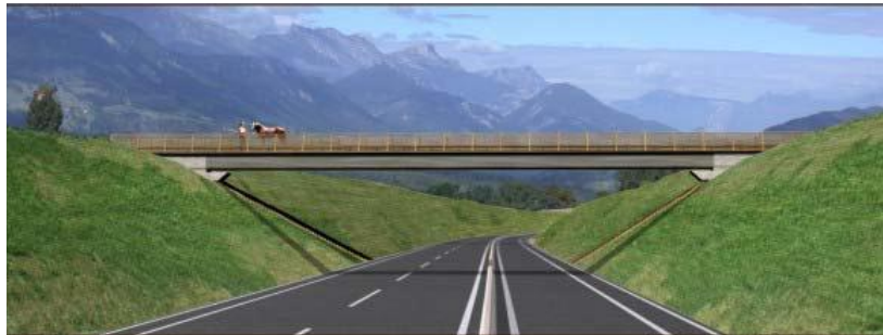
Figuur C15: Pont de la Chabotte over de A51
