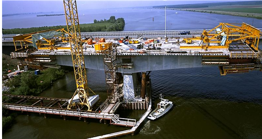
Figuur C8: de Tweede Stichtse Brug in aanbouw
