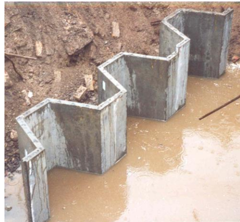
Figuur C26: De damwand (2003) in C105/120 in vergelijking met C55/65
