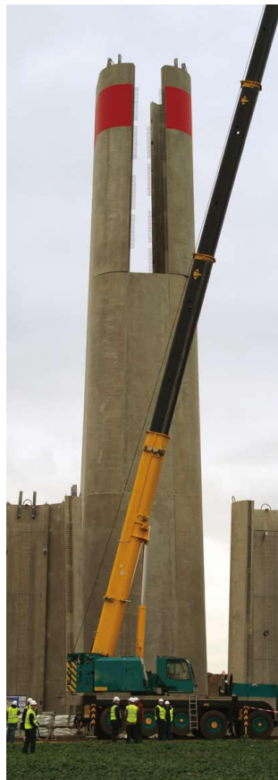
Figuur C31: Assemblage van een windmolenmast
