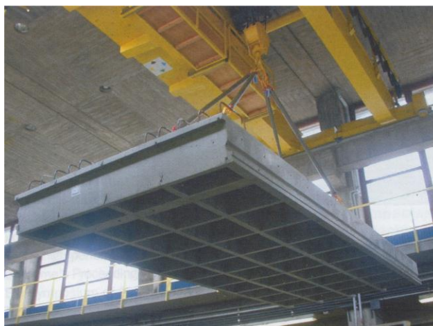
Figuur C18: Cassette-brugdekelement
