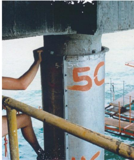
Figuur C6: Bekisting rond een aangetaste steigerpaal
