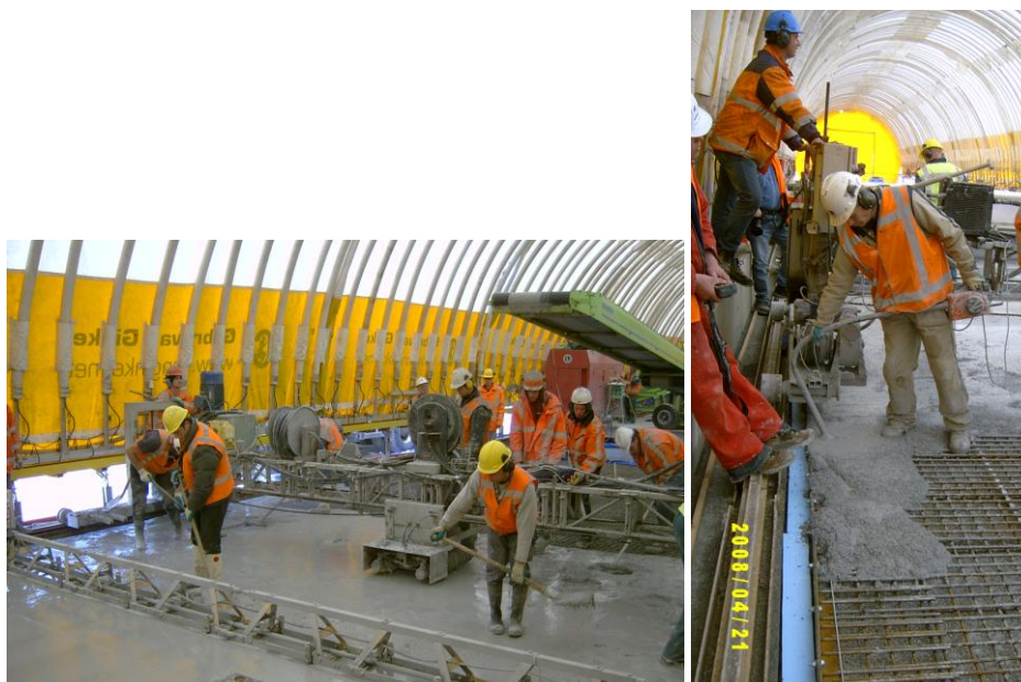
Figuur C24: Stortfront op een stalen brug
