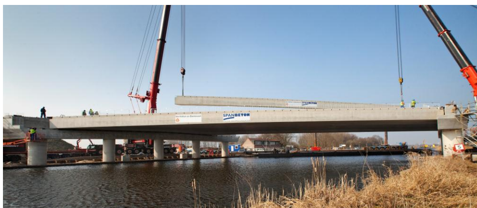
Figuur C9: Kokerliggers in de Westrandweg over de Ringvaart
