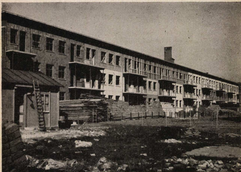
Verschillende muurconstructies aan de achterzijde van het proefwoningencomplex aan de Fazantstraat te Rotterdam.
