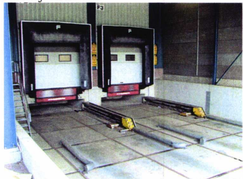
Figuur 19 Laadstations op de goede hoogte
