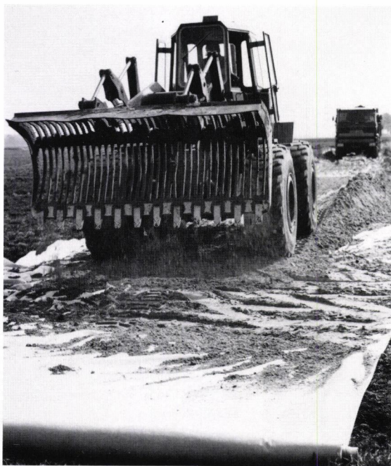
De draagkracht van transportwegen op een bouwterrein kan onder meer worden verbeterd door een laag draagkrachtige grond op een folie aan te brengen.
