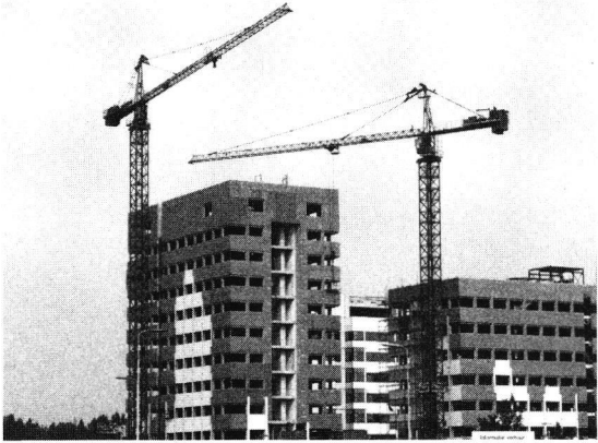
Twee torenkranen op één bouwwerk moeten op ongelijke hoogte staan. De gieken mogen niet binnen elkaars bereik komen.
