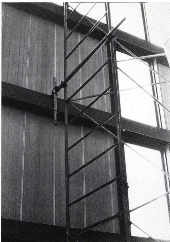
Koppeling van hoge steiger aan staalconstructie.
