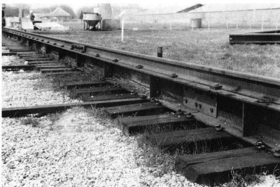
Rail op stalen langsligger en dwarsliggers
