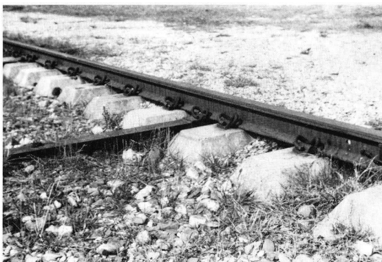
Rail direct op betonnen dwarsliggers
