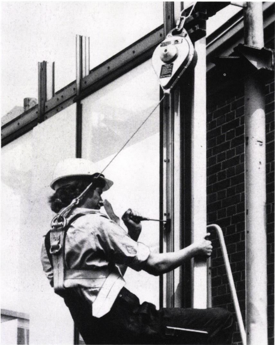
Valstopapparaat in gebruik bij reparatiewerkzaamheden aan een gevel
