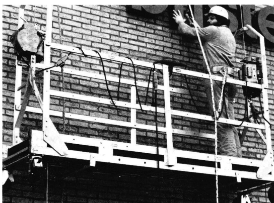
Valbeveiliging bij het werken in een hangsteiger door middel van een lijnklem, waarmee zowel op- als neerwaartse beweging mogelijk is
