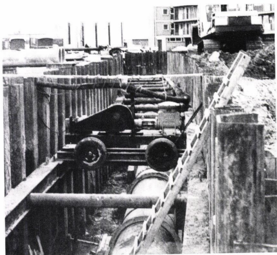
De werkbreedte in de sleuf moet minimaal 60 centimeter zijn.
