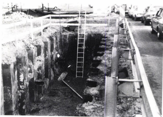
Voorbeeld van het gebruik van hekwerk en vangrail om te voorkomen dat personen in put of sleuf vallen.
