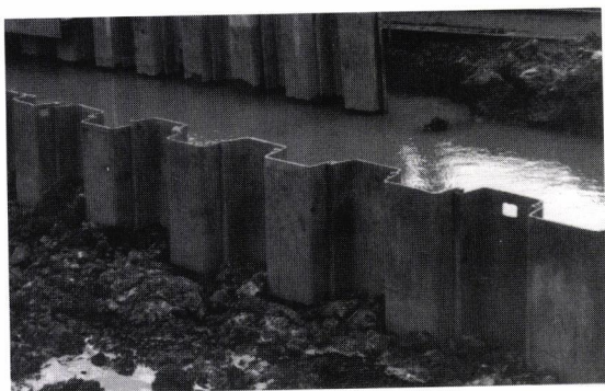
Voorbeeld van afscherming door middel van damwandplanken
