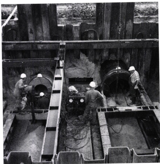
Bouwput voor het doorpersen van een buis onder een spoorbaan
