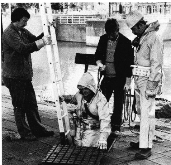
Uit veiligheidsoverwegingen is het noodzakelijk om bij rioolinspecties minstens met zijn tweeën af te dalen.
