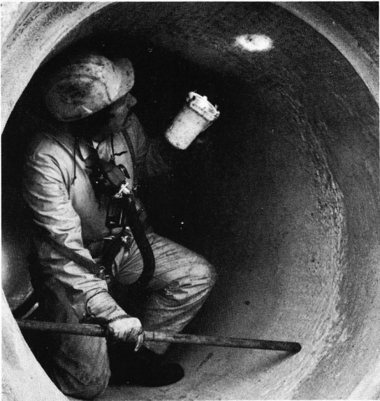
Uitrustingsstukken van medewerkers die werkzaamheden in put of riool uitvoeren: persluchtapparaat, explosievrije zaklantaarn, acoustisch alarm voor onverwacht optredende gasconcentratie, steunstok.
