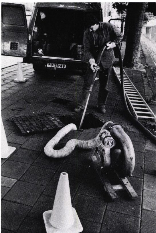
Het is aan te raden de wanden van de put schoon te spuiten vóórdat men zich erin begeeft.
