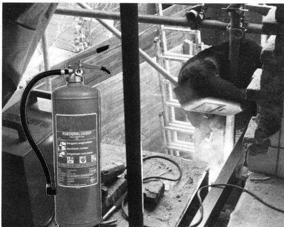
Op de lasplek moeten voldoende blustoestellen binnen handbereik aanwezig zijn.
