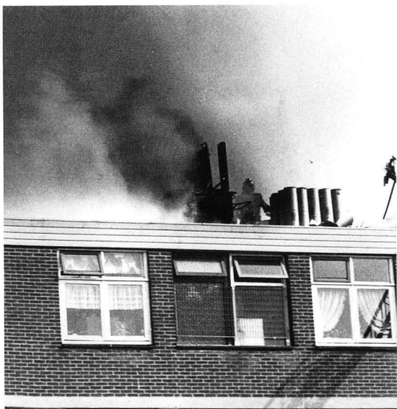
Het brandgevaar bij dakbedekkingswerkzaamheden is groot omdat wordt gewerkt met open vuur in combinatie met brandbare materialen.
