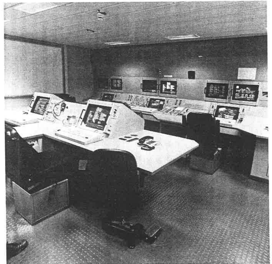
Technische centrale M-fregat
