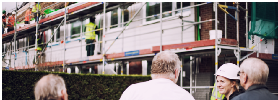
Figuur 4: Renovatie van de woningen
