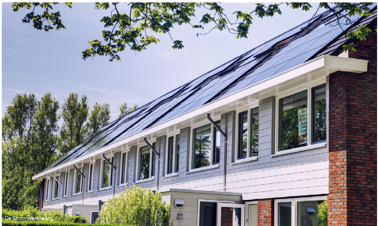
Figuur 1: Woningen Heerhugowaard voor en na renovatie.
