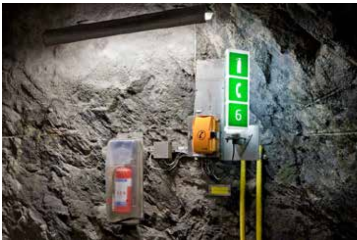
Illustration 12a - Torrnkogsstunnel north Stockholm (Sweden)
