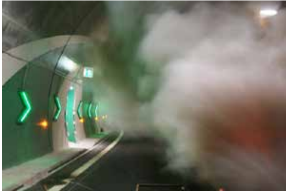
Illustration 13a - Bois de peu tunnel (France)
