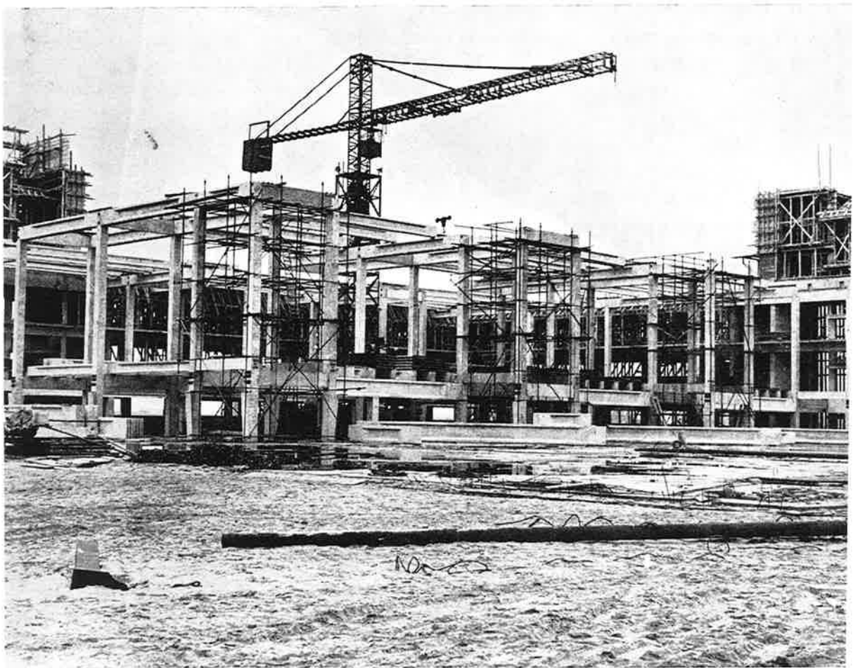
T.N.O.-complex Zuidpolder te Delft in aanbouw. Situatie einde 1959
