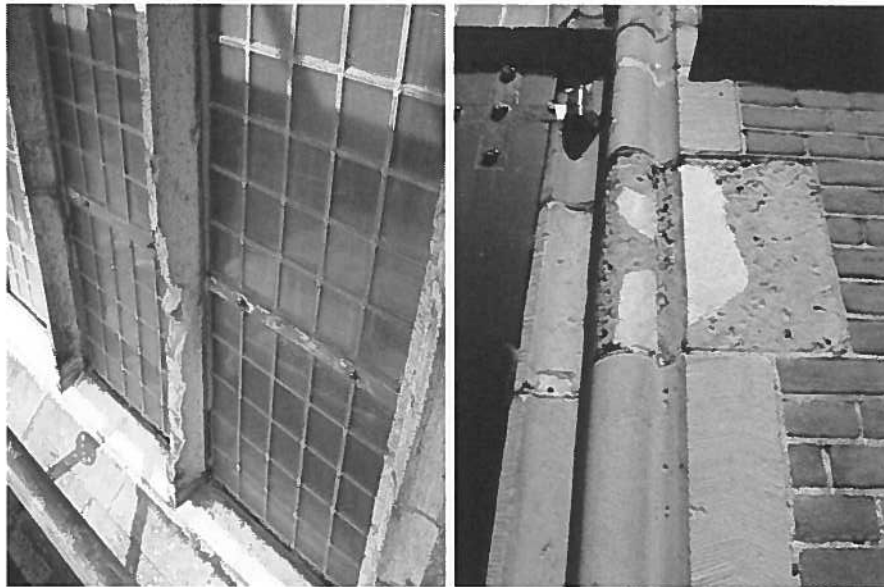
Fig. 1 (links). Scheurvorming tufsteen (Pieterskerk, Leiden).
