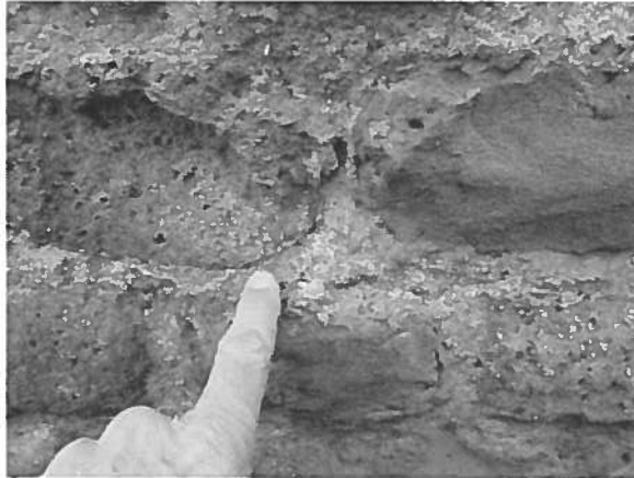
Fig. 6. Steenreparatiemortel toegepast op tufsteen (De Burcht, Leiden).
