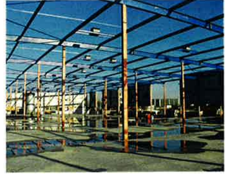
Figuur 7 - Opslagloods te Hoogvliet in aanbouw.
