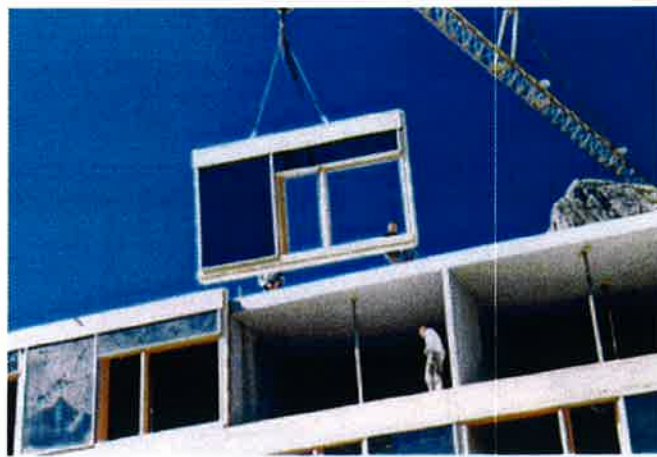
Figuur 3.11 Voorbeeld van een geprefabriceerde gevelelement met zonnecollector voor een flatwoning (Foto: Werner Weiss, Gleisdorf, Oostenrijk).
