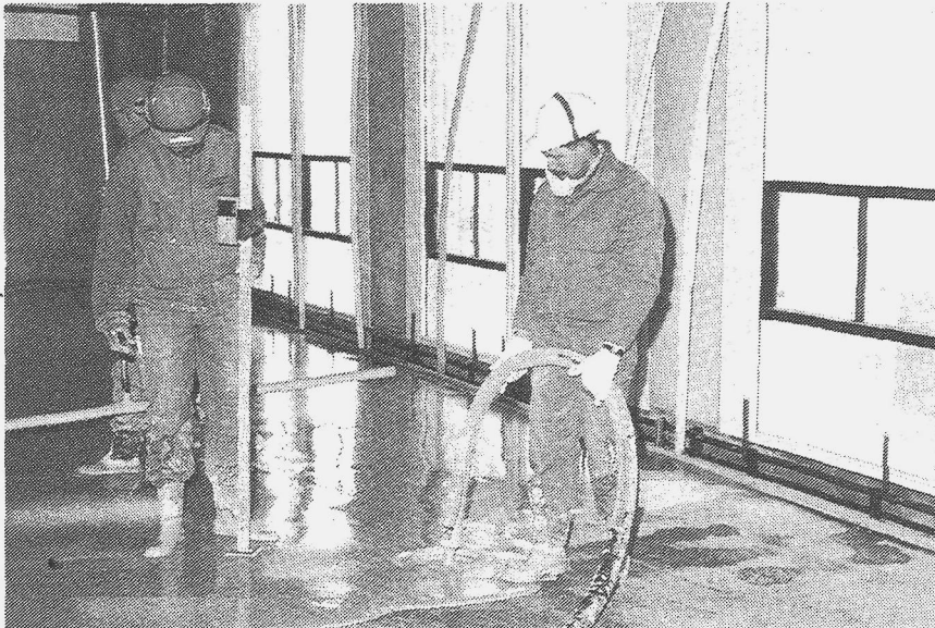
Figuur 4. Het aanbrengen van een gietvloer
