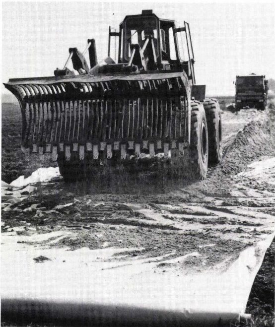
De draagkracht van transportwegen op een bouwterrein kan onder meer worden verbeterd door een laag draagkrachtige grond op een folie aan te brengen.
