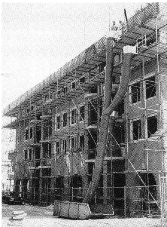
De combinatie van stortkoker en container zorgt voor een effectieve afvoer van afval en voorkomt struikel- en brandgevaar.
