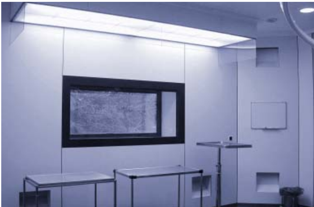
Fig. 8 Opdekplaats in een operatiekamer Op deze operatiekamers wordt opgedekt onder een separaat downflowplenum. Ook is hier het raam te zien met uitzicht op de omgeving.
