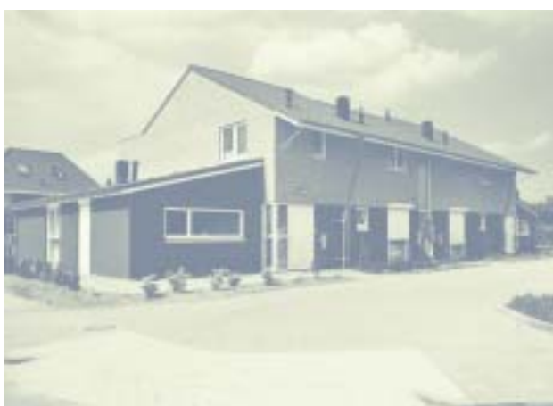
Afb. 7 Huisvesting voor de categorieën licht en zwaar in één gebouw
