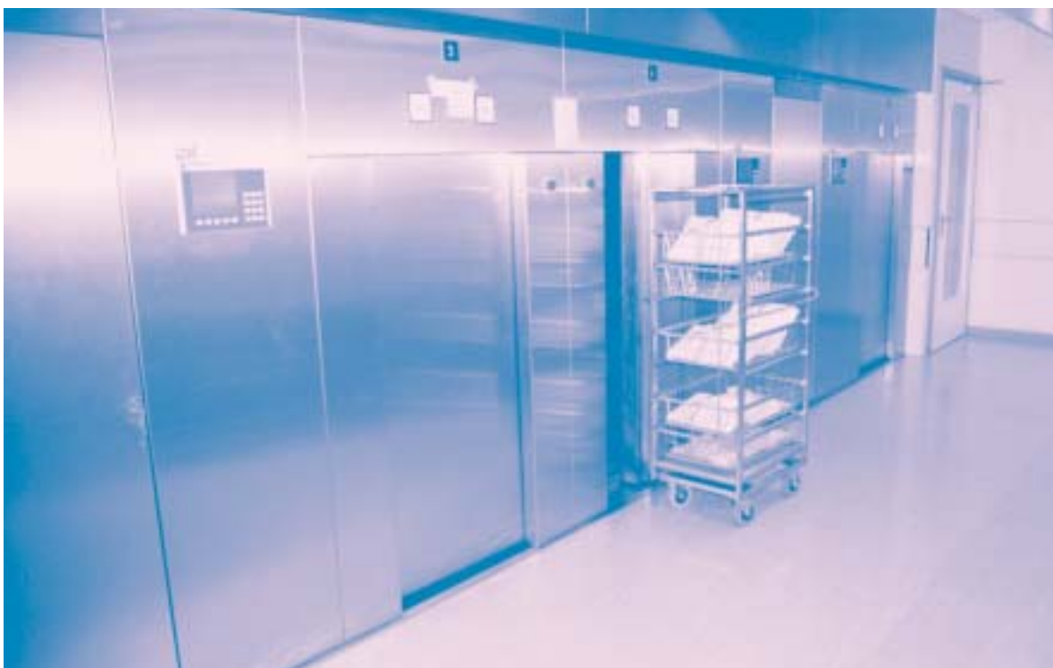
Afb. 5 Sterilisatoren: de verpakte goederen staan in de pakketteerruimte op beladingswagens klaar om gesteriliseerd te worden.
